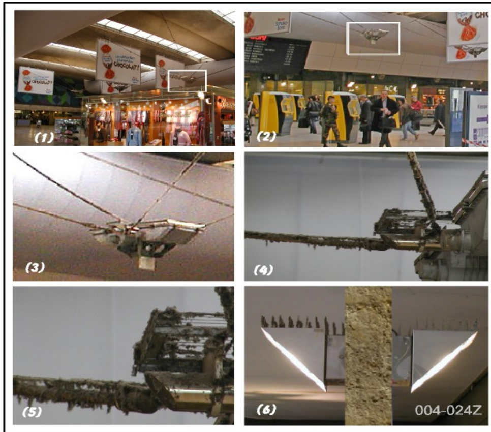
Figur 8-1(1-6) T-banestasjonen Gare de Montparnasse-Bienvenue rundt 2008 og støvansamlinger som skyldes fotoionisering.
