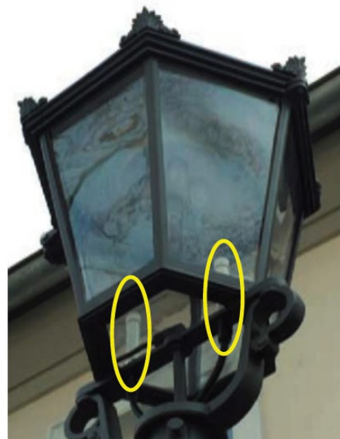
To antenner diskret montert inni gatelykta (markert med gult)
