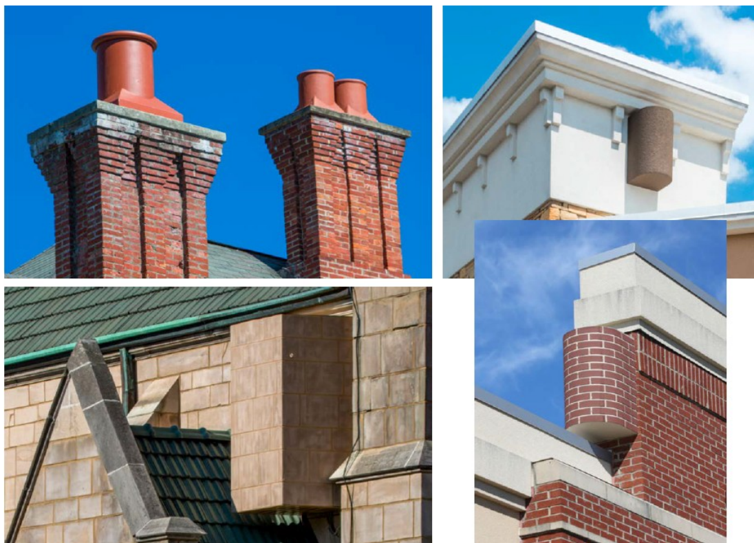
Bilde 6: «InvisiWave™»-forkledninger rundt små celler på bygninger [5]
