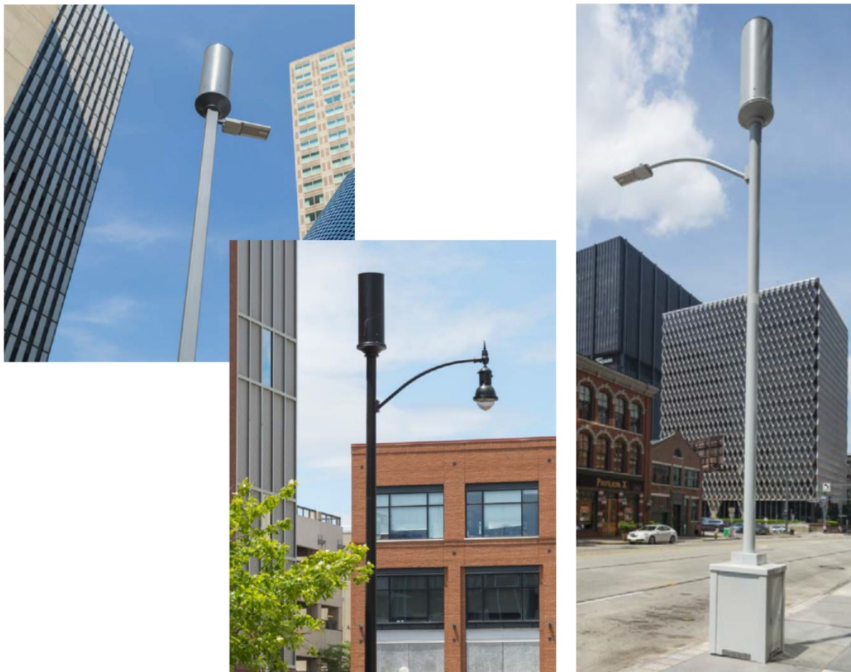
Bilde 5: «InvisiWave™»-forkledninger rundt små celler på lysstolper [5]
