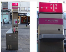
Bilde 1: Mikroceller for telekom med LTE-mobilnett («hotspots») i et fotgjengerområde. Slike har vært vanlige en god stund.
